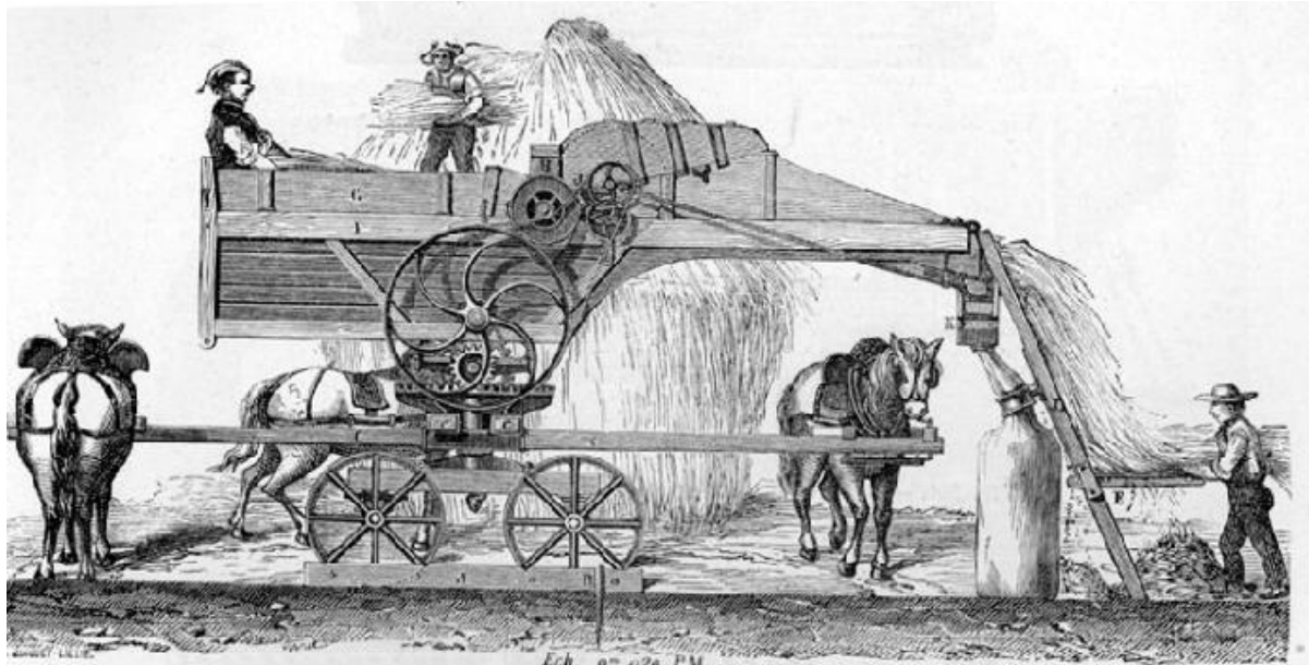
Fig. 348. — Batteuse Damey à manège direct placé sous la batteuse. Ech. 02 026 PM.
