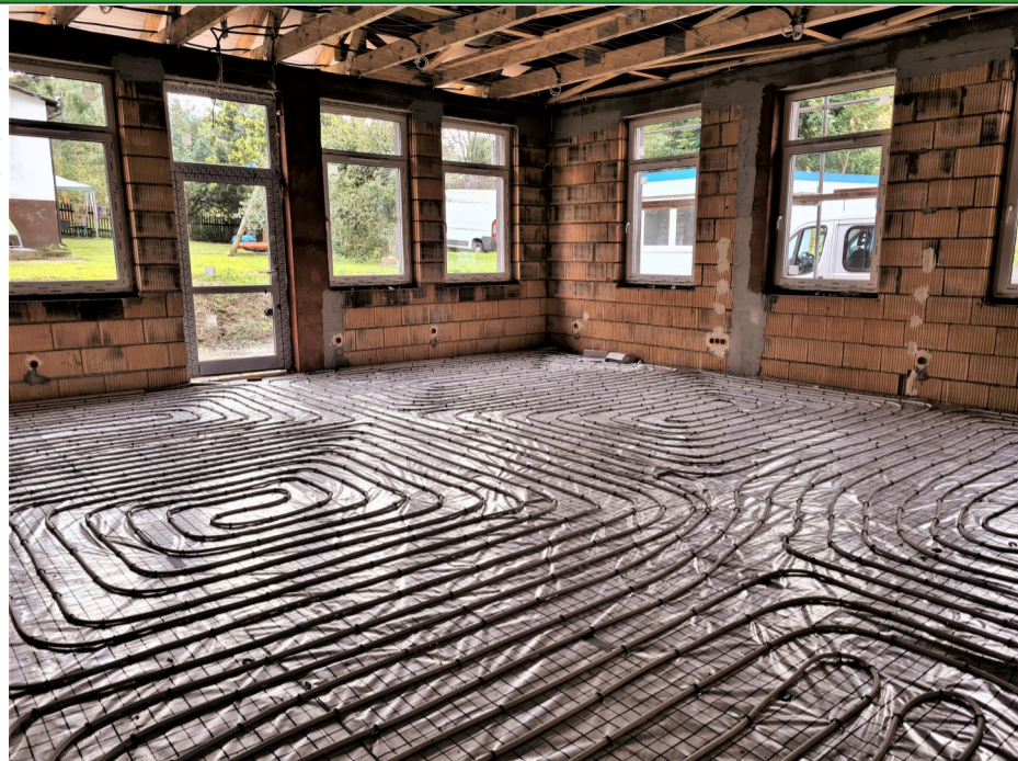
► Instalacja ogrzewania podłogowego (fot. Hubert Tyndyk)
