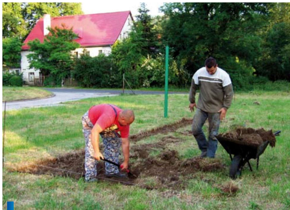
Uczestnicy akcji każdą wolną chwilę poświęcali pracy przy odbudowie boiska
