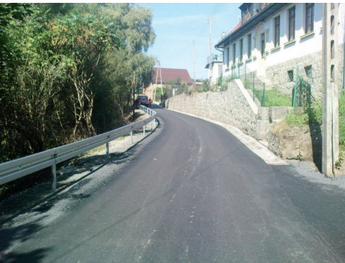
► Efekt końcowy inwestycji (fot.UG) niała im przejazd. Remont drogi planowano już kilka lat temu. Zrealizowano go ze środków rządowych na
